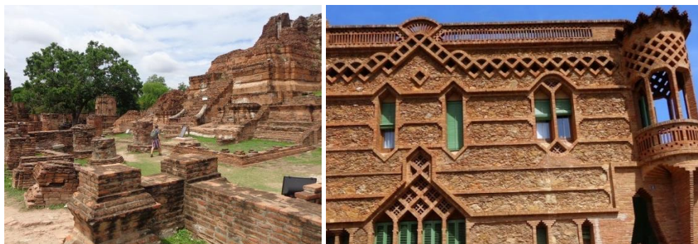
Слика 9.1 Згради од тула во Ајутаја (Тајланд) и Барселона (Шпанија)
