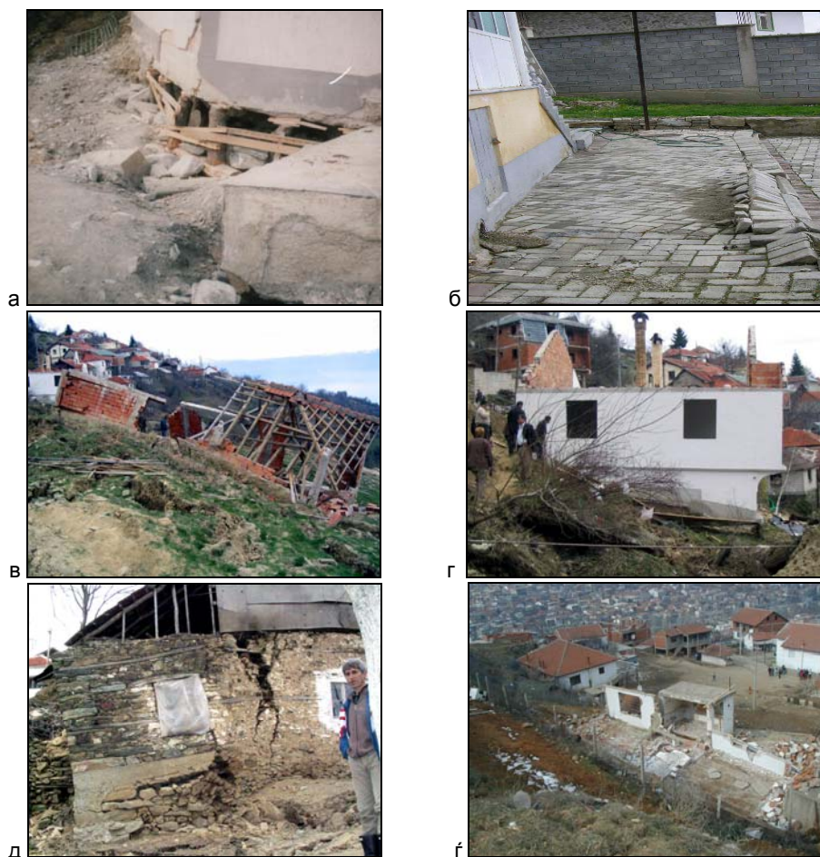
Слика 9.80 Оштетувања на објекти во зависност од положба во тело на свлечишта: а - оштетување на објект во близина на бочна граница кај свлечиште во с. Веле Брдо, б - делумна ротација и избивање на зоната на свлекување на предниот дел од објект зафатен со подножично свлекување за свлечиште во с. Боговиње, в - целосно уништен објект во средишен дел на свлечиште во с. Јеловјане, г - транслаторно поместен објект во свлечиште кај с. Јеловјане со речиси задржана конструкција, д - пукнат објект на средина поради фундаирање на граница на нестабилна со стабилна маса во с. Јеловјане, е - комплетно уништени објекти во чело на свлечиште (средишен дел и десно - долу на фотографија), и скоро неоштетени транслаторно поместени објекти (горен дел од фотографија) за свлечиште „Рамина“ во Велес
