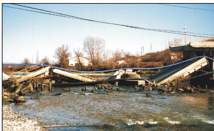
Слика 15.4 Рушење на мост преку река Црна во близина на Росоман поради ерозија на темелната основа (фото Ц. Поповска)
