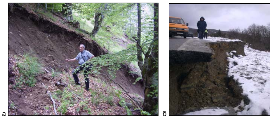
Слика 9.69 Примери за изглед на челна пукнатина на свлечишта: а - свлечиште на патот од с. Злетово до брана „Кнежево“ б - свлечиште на патен правец М - 5 од Ресен кон Битола
