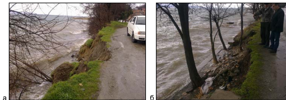
Слика 9.50 Зона на локално поткопување на езерски брег на Охридско Езеро во близина на с. Пештани: а - поткопување на брегот, б - поткопување при постоење на изведен ѕид и брежна вегетација за случај на екстремно висок водостој на езерото во тек на месец февруари 2010 година
