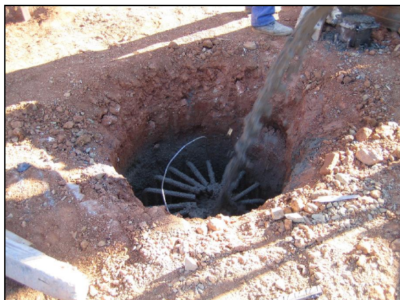
Слика 9.119 Фаза на бетонирање на една дупнатина за армирано - бетонски кол во кој е вметната арматурата
