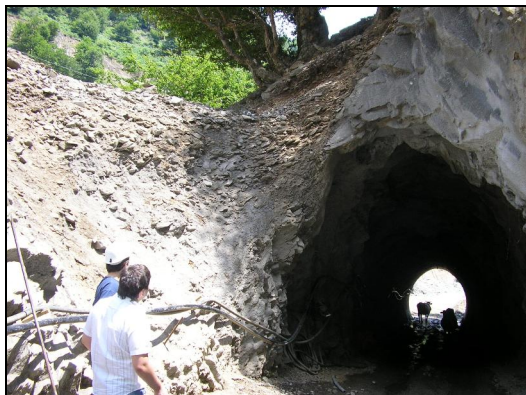
Слика 15.45 Обрушување на влезен дел од тунел на Саска Река, Македонска Каменица заради мал надслој од сипаришен материјал
