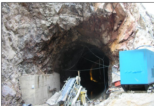
Слика 15.40 Потенцијално нестабилни и отпаднати блокови во излезен (портален) дел и во свод кај опточен тунел на брана „Света Петка“ на реката Треска
