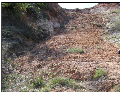
Слика 9.172 Течиште во глиновити карпи на косина од површински коп за јаглен „Суводол“
