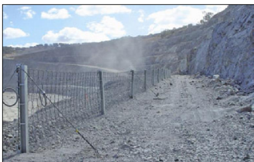
Слика 9.163 Комбинација на замка за блокови во вид на еластична мрежа и простор за одронување пред косина
