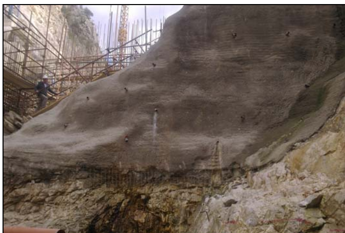
Слика 16.13 Примена на прскан бетон во комбинација со арматурна мрежа и дренажни цевки за заштита на ископ за темелна јама кај браната „Света Петка“ на реката Треска
