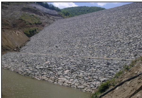
Слика 13.7 Кршен ретен камен за облагање на возводна косина на браната „Кнежево“ - Пробиштипско (фотографија од фаза на прво полнење на браната)
