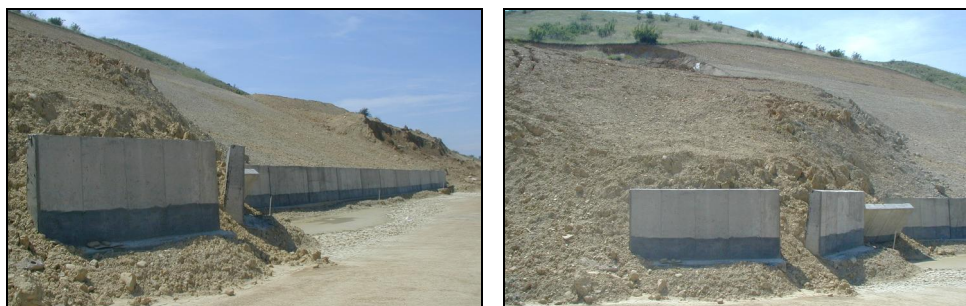
Слика 9.129 Транслаторно поместување на плитко фундиран потпорен сид кај автопатот Е-75 од Неготино - Демир Капија, деформиран во сама фаза на изведба (поглед од различни позиции)
