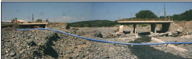
Слика 9.27 а - Рушење на мостот на Анска Река (Валандовско) заради ерозија на левиот речен брег; б - рушење на мостот на Мрзенска Река - Гевгелиско при појава на интензивни врнежи во тек на 2004 година
