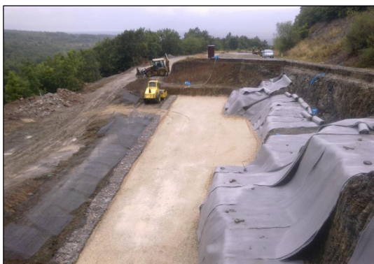
Слика 9.116 Санација на свлечиште на магистрален пат М-5 меѓу Ресен и Битола со комбинација на целосно растеретување на свлечена маса и потпирање со систем од габиони и армирана земја
