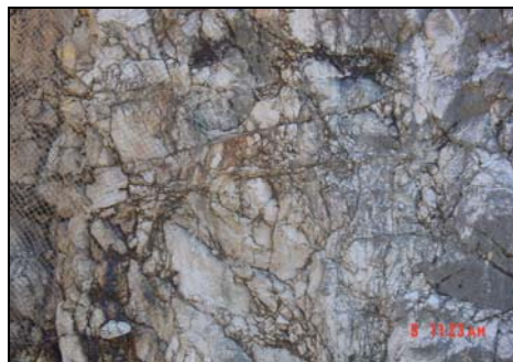
Слика 12.17 Доста испукани мермери од пат за брана “Света Петка” со повеќе системи на пукнатини (GSI=30-35)
