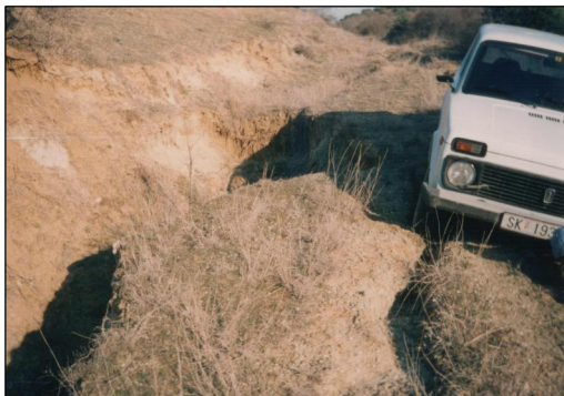
Слика 15.24 Зона на еродирање на терен по траса на нафтовод од рафинерија „Окта“ до Солун
