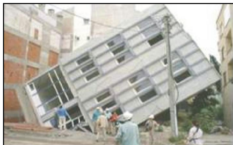
Слика 11.6 Ефекти од ликвидација во вид на превртување на зграда во градот Адапазар -Турција, Јузер и др., 2005
