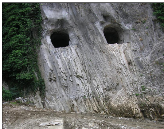
Слика 15.44 Приказ на специфична положба на два паралелни доводни тунели за брана „Матка“ - Скопско
