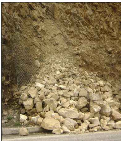
Слика 9.162 Оштетена заштитна патарска мрежа за косина на автопат Е - 75, поради појава на одрон со поголеми блокови на делница од Катланово до Велес (фото С. Николов)
