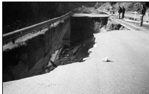
Слика 9.28 Ерозија на темел на потпорен сид кај пат во Струмичко, со поткопување на сидот и пропаѓање на патот во заднината на сидот
