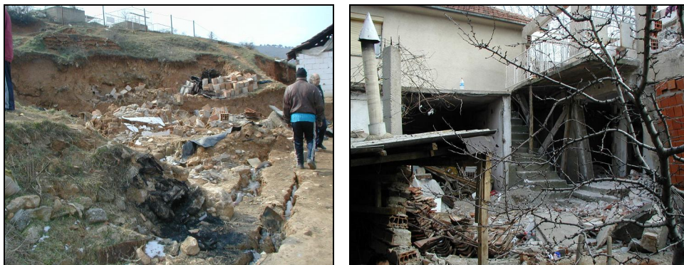
Слика 9.141 Примери за оштетувања на објекти во челото и во телото на свлечиштето
