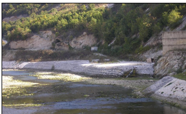
Слика 13.8 Ретен камен во габионски ѕидови за заштита од ерозија кај излез од опточен тунел на брана „Козјак“ - Скопско
