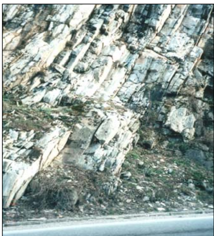
Слика 6.14 Анизотропија на испуканоста кај карбонатни шкрилци (засек на патот Росоман - Прилеп)
