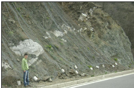
Слика 9.161 Заштитна патарска мрежа за косина на автопат Е 75, делница од Катланово до Велес (фото С. Николов)
