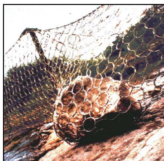
Слика 9.164 а - Заштитни бариери од мрежи составени од апсорбирачки прстени со голема моќ за задржување на одронети блокови, б - детаљ на еден апсорбирачки прстен
