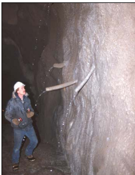
Слика 16.17 Дренирање на подземен ископ со помош на едноставни пластични дренажни цевки
