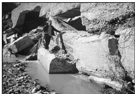
Слика 9.28 Ерозија на темел на потпорен сид кај пат во Струмичко, со поткопување на сидот и пропаѓање на патот во заднината на сидот
