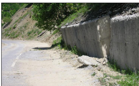
Слика 9.129 Транслаторно поместување на плитко фундиран потпорен сид кај автопатот Е-75 од Неготино - Демир Капија, деформиран во сама фаза на изведба (поглед од различни позиции)
