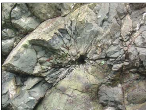
Слика 16.19 Зона на дробење околу една минска дупнатина на пристапен патот за браната „Кнежево“ - Пробиштипско
