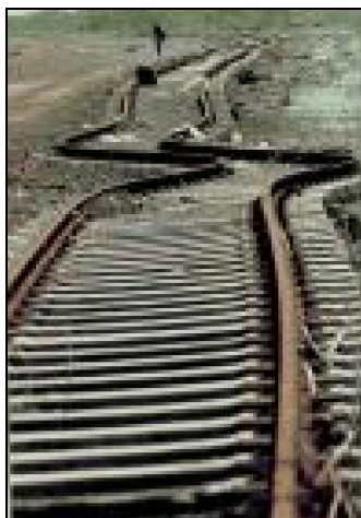
Слика 11.8 Деформации на железничка линија со странично поместување на почвата при ликвидација
