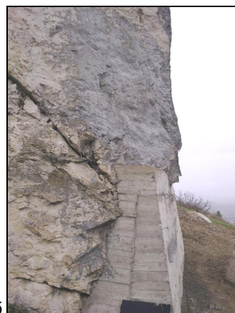
Слика 9.166 а - Заштита на косини со обложен ѕид на патот за браната “Света Петка”, б - потпорен ѕид со подсидување на потенцијално нестабилен блок во дно и анкери во горна зона над соборен храм Свети Пантелејмон во Велес
