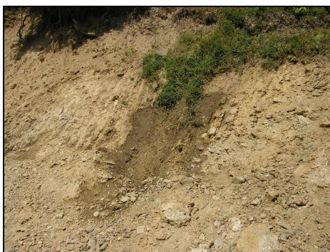
Слика 8.28 Пиштевина на косина од пат М. Каменица до рудникот Саса
