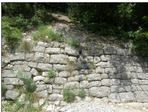
Слика 9.169 Потпирање на телото на сипар со реден камен на дел од стара железничка пруга Чачак - Пожега во Р Србија (фото Б. Аболмасов)
