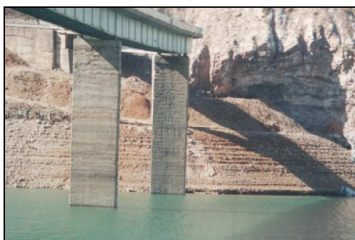
Слика 15.64 Поглед кон крајбрежен столб на Мелнички мост по заштита со насип (во позадина е видлива лузна од одрон)
