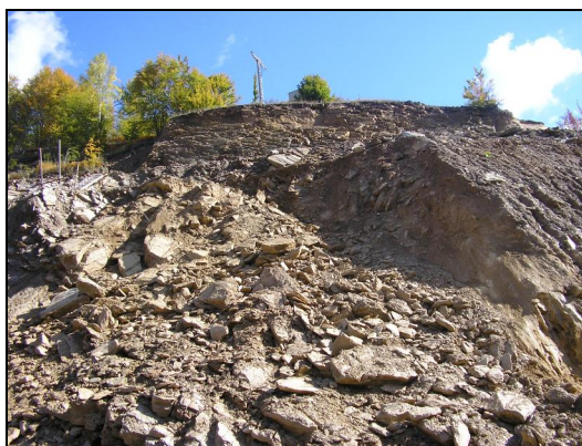
Слика 15.46 Појава на смолкнување на шкрилести карпи со неповолен пад во зона на излез од опточен тунел за брана „Кнежево“, Злетовско
