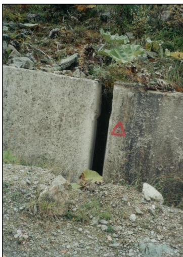
Слика 9.131 Нерамномерно поместување на одделни кампади од потпорен ѕид на патот за граничен премин кон “Луково Поле”
