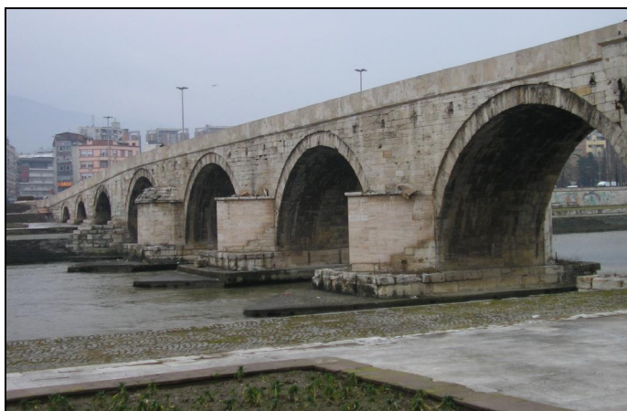
Слика 13.11 Камениот мост на река Вардар во Скопје, пример за примена на травертин -бигор како камен за сидање на мостовска конструкција
