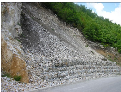
Слика 9.168 Потпирање на телото на сипариштето со габиони на пристапен пат од Скопје до брана „Света Петка“ (видливо е дека сипариштето поради стрмен наклон повремено се „прелива“ над габионскиот ѕид)
