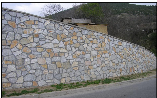
Слика 13.9 Примена на камен за зидање кај потпорни обложни ѕидови, с. Сопиште, Скопско
