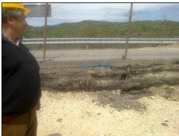
Слика 15.23 Приказ на деформиран насип на автопат Е-75 од Катланово до Велес, каде што се забележува надградуван асфалт и до 1 метар како компензација на слегнувањата
