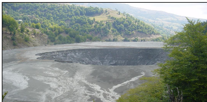
Слика 15.8 Појава на колапс во хидројаловиште на рудник Саса, поради ефект на вакуум при протекување на јаловина низ опточен тунел
