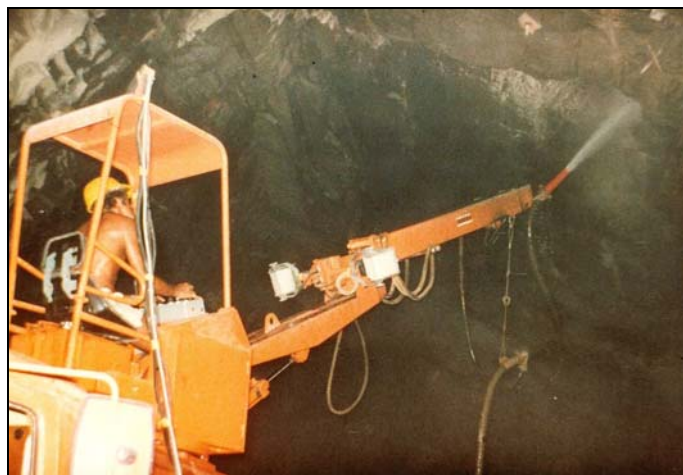
Слика 16.14 Опрема за прскан бетон во функција кај подземен објект
