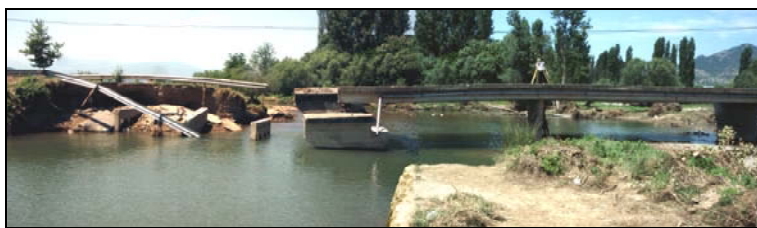
Слика 9.26 Појава на свлечиште на речен брег од реката Злетовица поради бочна ерозија: а и б - снимки на ист брег од различни позиции
