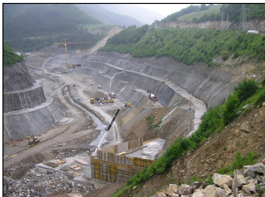
Слика 15.62 Заштита од идни загуби на вода на голем дел од акумулациониот простор на брана „Ц'нков камен“ – Р Бугарија со примена на анкерисување, прскан бетон, берми и други технички мерки (фото И. Русев)
