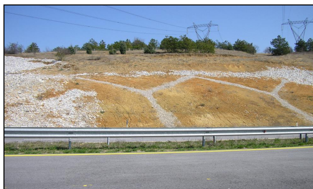
Слика 9.114 Санација на свлечиште од косина на автопат Е-75 со изведба на т.н. Y-дренажи чиј извод завршува со собирна дренажа на ниво на автопатот
