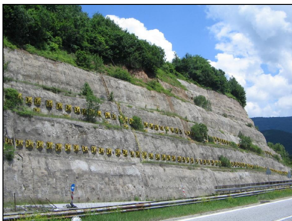
Слика 15.22 Приказ на систематски анкерисана косина со припрема на берми на определени висини (фото Б. Димитров)
