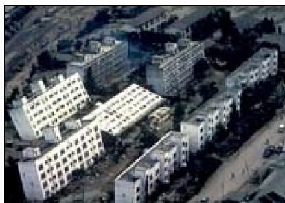
Слика 11.7 Ликвидација на терен при земјотрес во градот Ниагата - Јапонија, со целосно превртување на станбени објекти
