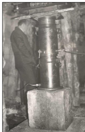
Слика 14.52 Подготвени блокови за испитување во истражна галерија на браната „Света Петка“ (лево) и оптоварен бетонски блок за испитување на деформабилност во истражна галерија на браната „Стрежево“ (десно)
