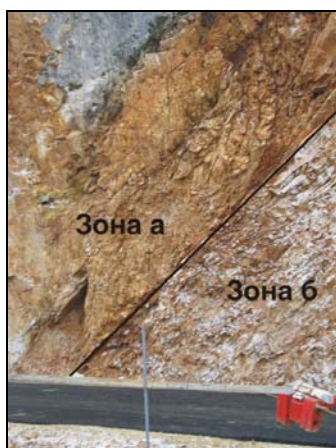
Слика 6.12 Две квазихомогени зони по параметар на испуканост и распаднаотост за мермери на патот за браната „Света Петка“
