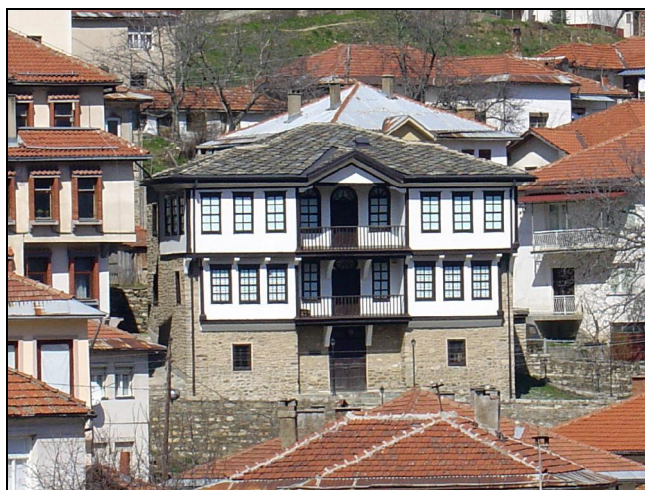
Слика 13.17 Примена на аргилошисти како покривен материјал (уметничка галерија во Крушево, фото Бл. Маркоски)
