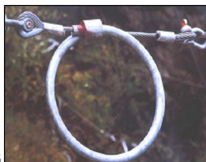
Слика 9.164 а - Заштитни бариери од мрежи составени од апсорбирачки прстени со голема моќ за задржување на одронети блокови, б - детаљ на еден апсорбирачки прстен
