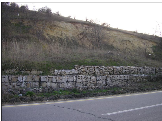
Слика 9.115 Санација на свлечиште од косина на автопатот Е-75 на дел од Катлановско брдо со изведба на габионски ѕидови
