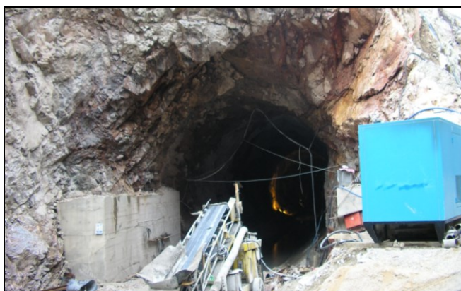
Слика 22.13 Потенцијално нестабилни и отпаднати блокови во влезен (портален) дел и во свод кај оптично-преливен тунел на браната „Света Петка“ на реката Треска
