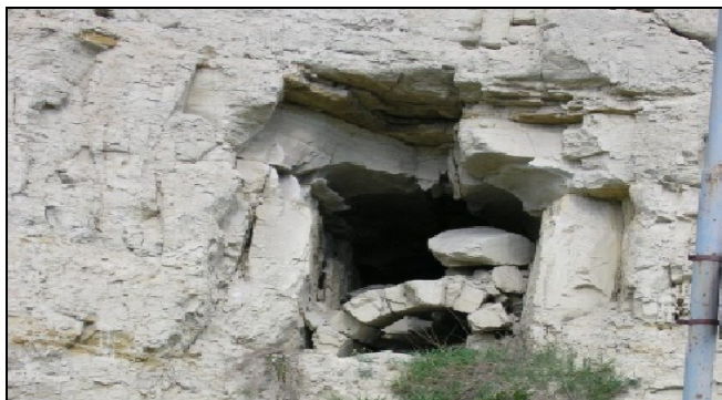
Слика 22.12 Лом на свод на отвор со мали димензии кај субхоризонтални слоеви комбинирани со два попречни пукнатински системи во карпи со слаб квалитет (лапорци за ископ кај Скопското Кале)
