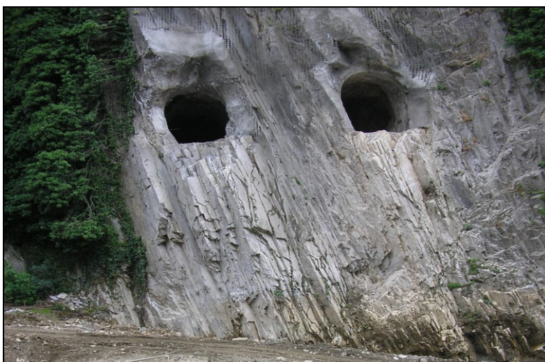
Слика 22.19 Приказ на специфична положба на два паралелни доводни тунели за браната „Матка“ – Скопско
