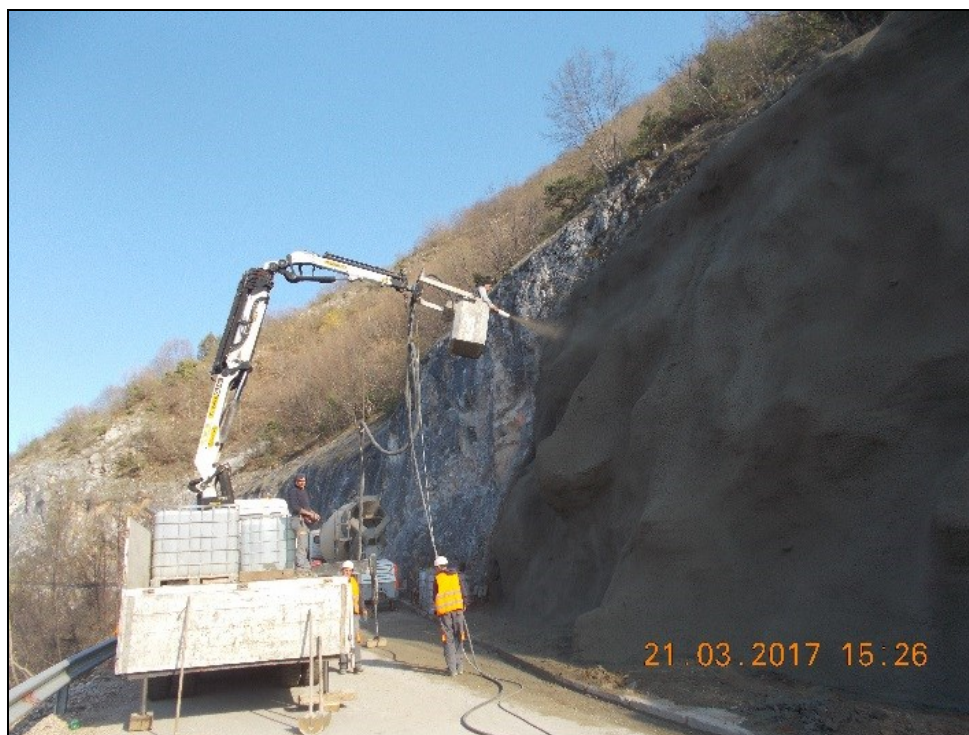
Слика 18.41 Опрема за прскан бетон преку дигалка и корпа, применета при заштита на косини за пристапен пат за браната „Света Петка“ (фотографија на З. Николовски)
