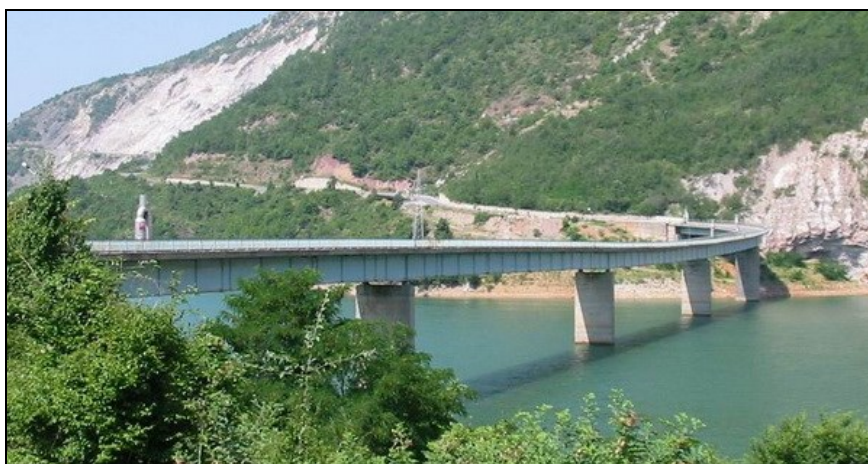
Слика 21.33 Поглед кон Мелнички мост – Дебар, преку акумулацијата Шпилје – пример за сложени услови на фундаирање поради појави на одронување на гипсни наслаги, кои се склони кон хемиско растворање и карстификација, појава на езерска абразија, како и постоење на активен расед на десниот брег со доминантно хоризонтално поместување
