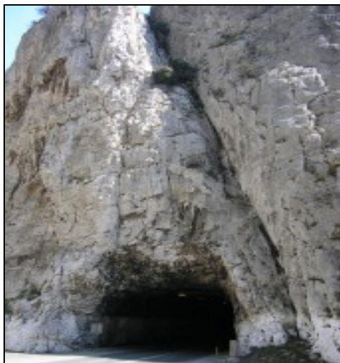
Слика 10.14 Масивни, до слабо услоени јурски варовници, кај тунел во близина на Демир Капија, квазиизотропен до ортотропен масив
