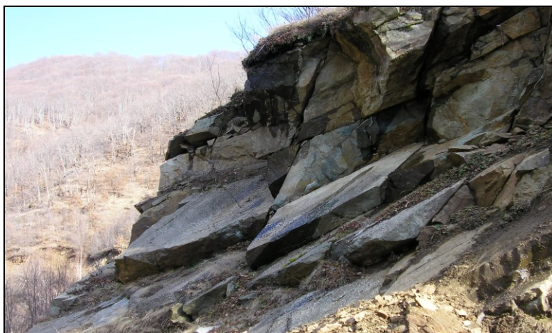
Слика 2.3 Приказ на систем на коси пукнатини по фолијација и два попречни системи на засек за пат до браната „Кнежево“ – Пробиштип, како пример за карпест масив во мал размер (фотографија од М. Јовановски)
