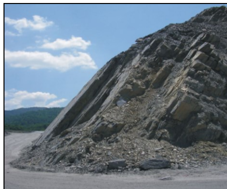
Слика 16.6 Косина од засек на автопатот за обиколницата на Скопје, во песочници и лапорци со класични предуслови за лом со свивање (buckling failure) (лево) и кинематски предуслови за лом со прекршување на косина од рудникот "Ржаново", Кавадаречко (десно)
