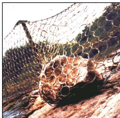
Слика 21.17 – Заштитни бариери од мрежи составени од апсорбирачки прстени со голема моќ за задржување на одронети блокови (лево) и детаљ на еден апсорбирачки прстен (десно)
