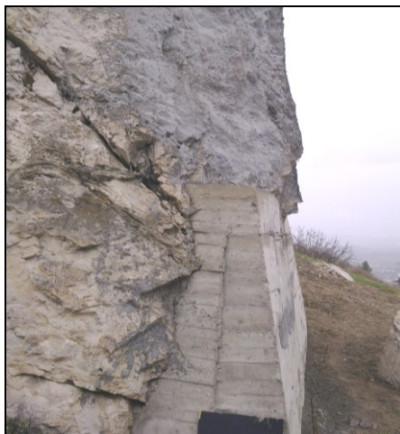
Слика 21.20 Пример за армирано-бетонски ѕид за потпирање на нестабилен блок над храмот Св. Пантелејмон, Велес (во горна зона блокот е анкерисан и заштитен со прскан бетон)
