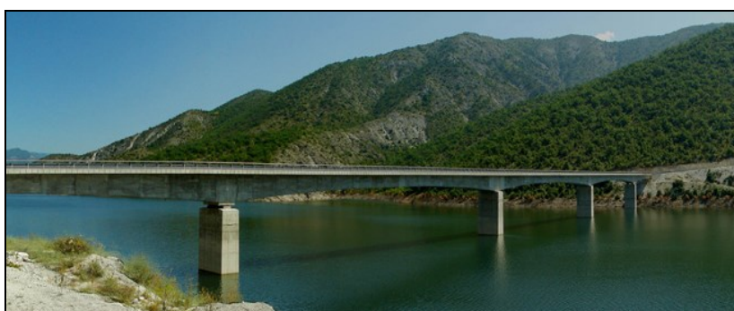
Слика 21.36 Поглед кон мостот Здуње преку акумулацијата Козјак во фаза на изградба (горе) и во услови на оформена акумулација (долу), фундиран врз мермерни маси (преземено од Николовски и Иванов, 2013)
