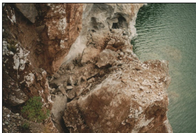
Слика 21.34 Одронување на блок во близина на Мелничкиот мост – Дебар, поради сложена комбинација на неповолни пукнатински системи, хемиско растворање и карстификација во гипсни наслаги и езерска абразија
