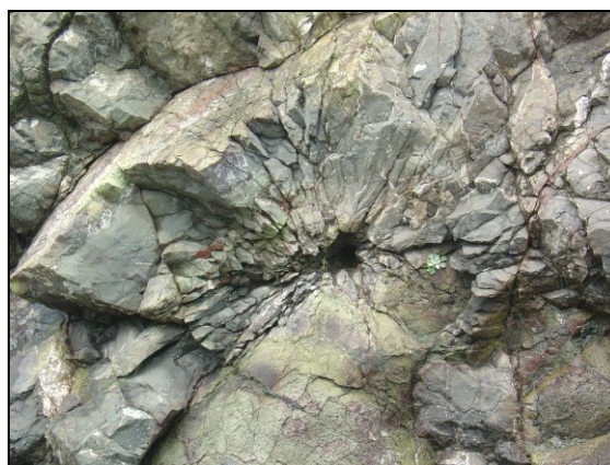
Слика 21.54 Зона на дробење околу една минска дупнатина на пристапен пат за браната „Кнежево“ – Пробиштипско
