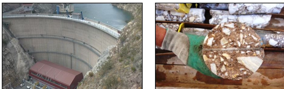
Слика 13.20 Поглед кон браната „Света Петка“, Скопско, (лево) и изглед на примероци извадени од телото на браната во зона на радијалните фуги, со видлива наполнетост со инјекциска маса (десно)
