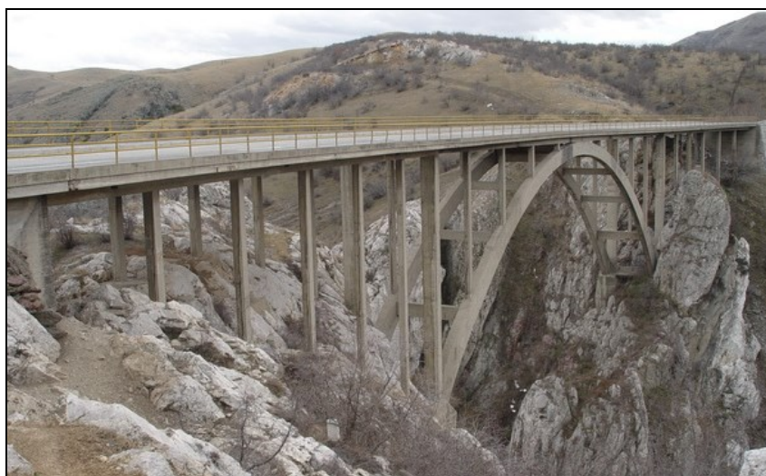
Слика 21.37 Поглед кон лачен мост M1-68D на автопатот Катланово – Велес, фундиран врз мермерни маси, со неповолни елементи на пад (фотографија од Т. Николовски, 2013)
