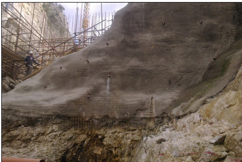
Слика 18.40 Примена на прскан бетон во комбинација со арматурна мрежа и дренажни цевки за заштита на ископ за темелна јама кај браната „Света Петка“ на реката Треска
