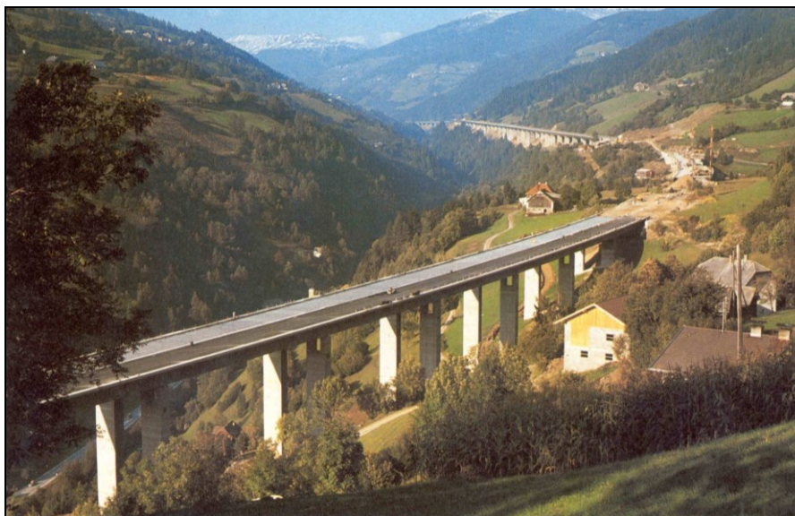
Слика 21.38 Приказ на една мостовска конструкција, каде што само 20 % од вкупните трошоци за изведба се поврзани со површинскиот дел, додека 80 % за темели и потпорни конструкции (со одобрение на Х. Брандл)
