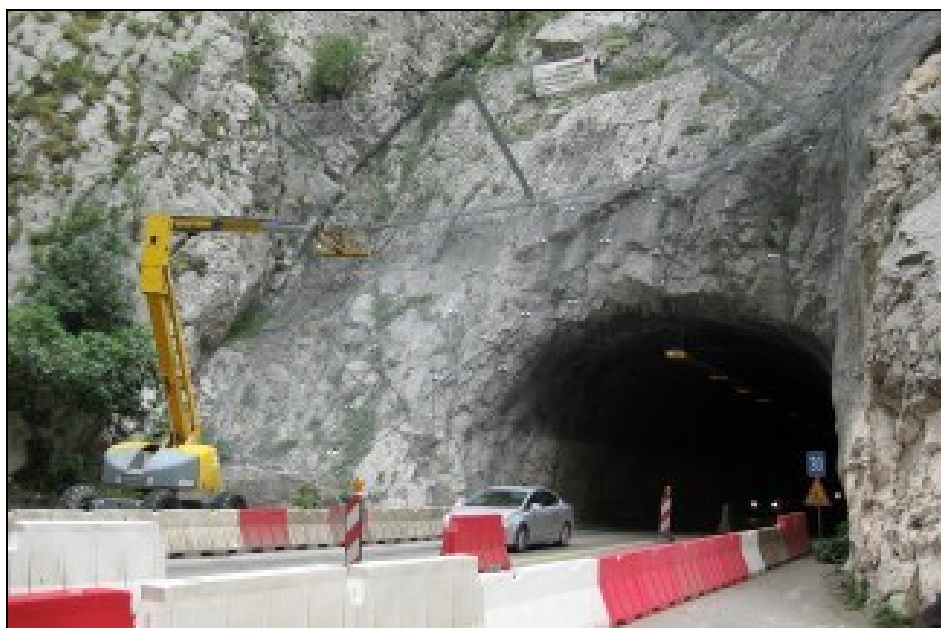
Слика 21.18 Заштитна бариера на над портал на тунелот кај Демир Капија
