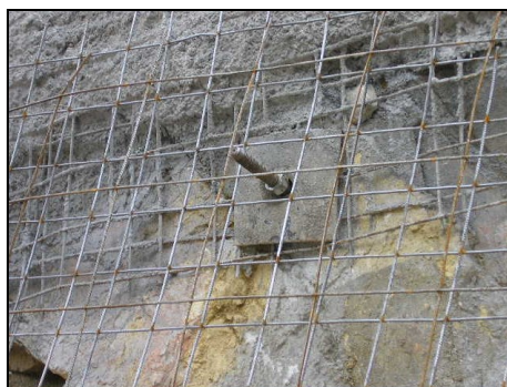
Слика 18.24 Детали на глава на вграден пасивен анкер од портален дел кај тунелот „Злетовица“ (лево) и блок на преднапрегнато сидро пред бетонирање вградено за санација на свлечиштето „Рамина“ во Велес (десно)
