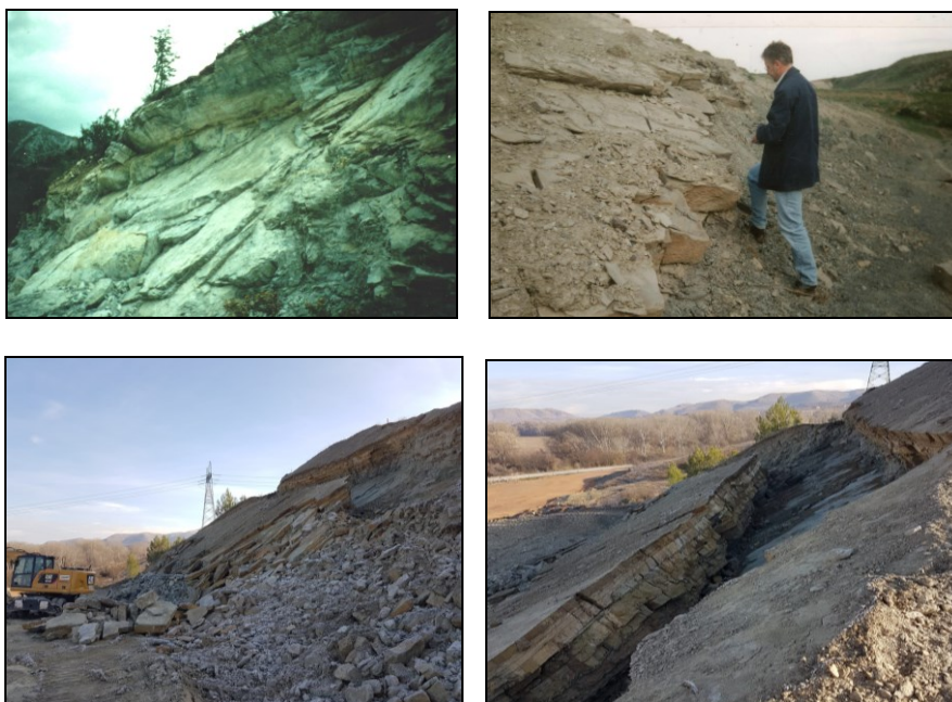
Слика 16.4 Рамнински лом кај мермери од засек на патот Здуње – М. Брод по рамнини на фолијација потсечени со тензиона пукнатина (горе лево), флишна серија склона кон рамнински лом од зона на нафтовод од Скопје до Солун (горе десно), појава на лом во флишни седименти на косина од патот Штип – Радовиш (долу лево и десно)
