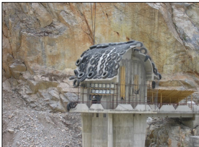
Слика 21.60 Еден начин на заштита на објект од евентуално отфрлени парчиња од карпа за случај на правење ископ со минирање во непосредна близина
