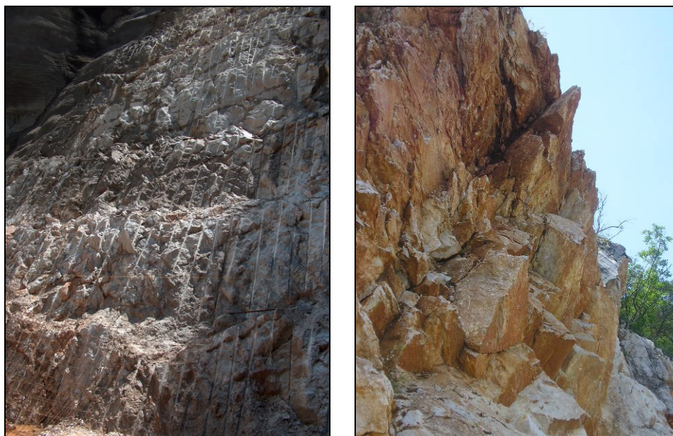
Слика 21.57 Мермери од ископ за темелна јама на браната „Св.Петка“, со техника на претходно создавање на пукнатини (лево) и мермери од пристапен пат за браната „Св.Петка“, изминирани со класична техника на минирање (десно)
