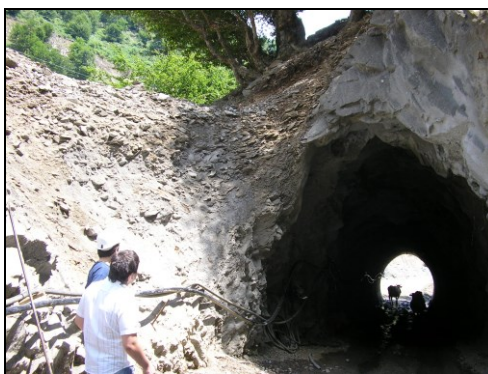
Слика 22.18 Рушење на влезен дел од тунел на Саска Река, Македонска Каменица, поради мал надслој од карпа, сипаришен материјал на дел од страна на ископот
