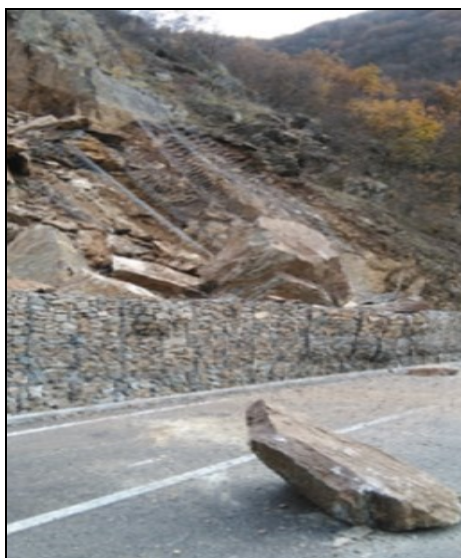
Слика 16.49 Одрон на патот Кочани – Делчево со приказ на делумно задржување на блокови со габионски ѕид како бариера
