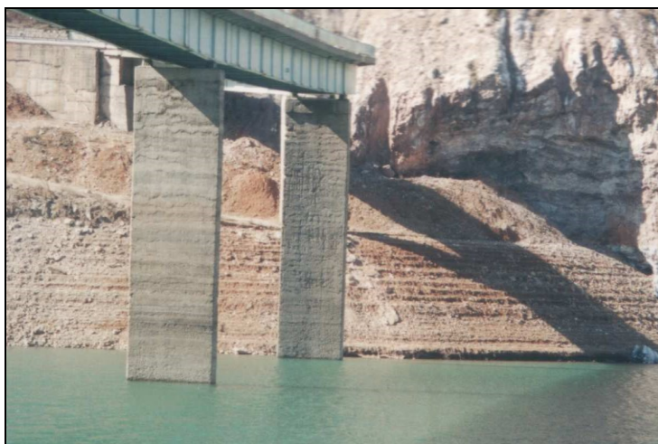
Слика 21.35 Поглед кон крајбрежен столб на Мелнички мост по заштита со насип и инекциони зафати (во заднината е видлива лузната од одронот)
