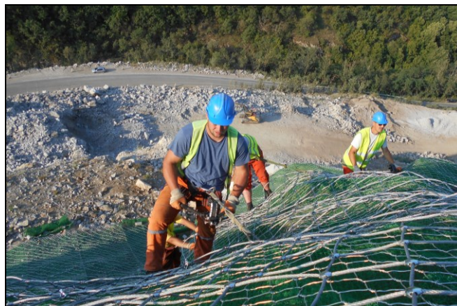
Слика 21.14 Поставување на заштитна челична мрежа за косина на експресен пат Штип – Радовиш, комбинирана со зелена геосинтетска мрежа и зајакната со салји (фотографија на Т. Јовановска)
