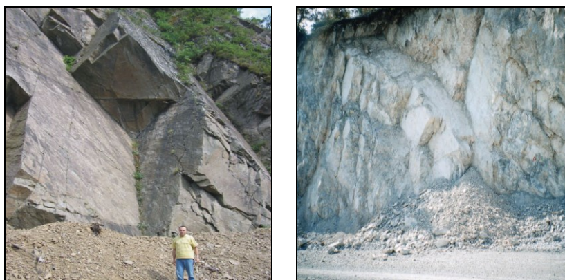
Слика 16.5 Клиновиден лом на косина од патот браната „Кнежево“ во комбинација на тензиона пукнатина во врвот на косината и две пукнатини (лево) и на патот Здуње – Македонски Брод (десно)
