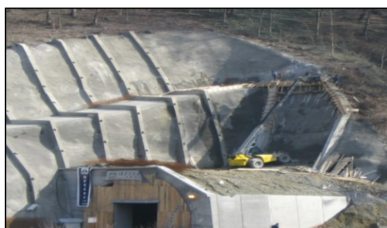
Слика 21.13 Заштита на косина со прскан бетон и армирано бетонски ребра за влез во тунелот „Мечково брдо“, кај Овчар Бања, Србија (фотографија од Б. Аболмасов)
