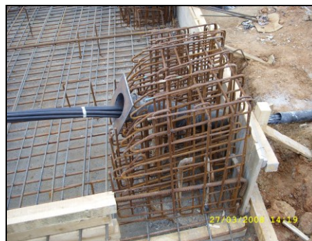
Слика 18.24 Детали на глава на вграден пасивен анкер од портален дел кај тунелот „Злетовица“ (лево) и блок на преднапрегнато сидро пред бетонирање вградено за санација на свлечиштето „Рамина“ во Велес (десно)
