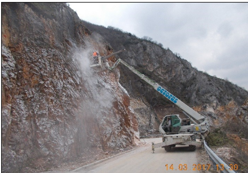
Слика 18.38 Приказ на постапки за дупчење и поставување на SN-анкери при заштита на косини за пристапниот пат за браната „Света Петка“ (фотографија од З. Николовски)
