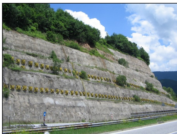
Слика 21.9 Приказ на систематски анкерисана косина со подготовка на берми на определени висини (фотографија од Б. Димитров)
