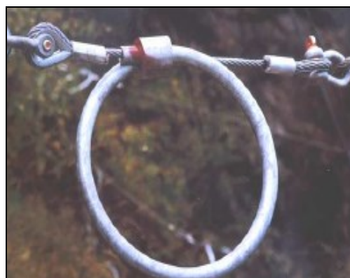
Слика 21.17 – Заштитни бариери од мрежи составени од апсорбирачки прстени со голема моќ за задржување на одронети блокови (лево) и детаљ на еден апсорбирачки прстен (десно)
