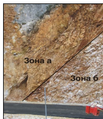
Слика 6.2 Две квазихомогени зони по параметар на испуканост и распаднаст за мермери на патот за браната „Света Петка“ (десно) и хетерогена градба на масив со измена на литологија во хоризонтален правец кај палеозојски комплекс составен од мермери (А), шкрилести карпи (Б и В) кои се одвоени и со раседи (P1 и P2) на патот Велес - Градско (лево)
