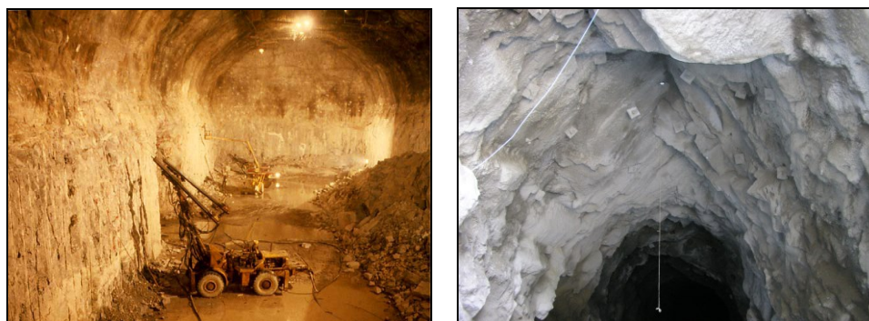
Слика 22.47 Ископ за подземен објект миниран со метода на мазно минирање (лево) и кај опточен тунел на Саска Река изминирани со класична техника на минирање (десно)
