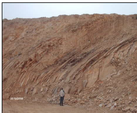
Слика 16.6 Косина од засек на автопатот за обиколницата на Скопје, во песочници и лапорци со класични предуслови за лом со свивање (buckling failure) (лево) и кинематски предуслови за лом со прекршување на косина од рудникот "Ржаново", Кавадаречко (десно)
