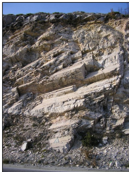
Слика 16.7 Косина на пристапниот пат за браната „Света Петка“ со предуслови за лом со превртување (лево) и потенцијално нестабилни блокови, формирани од три системи на пукнатини на патот Росоман – Прилеп на превој Плетвар (десно).
