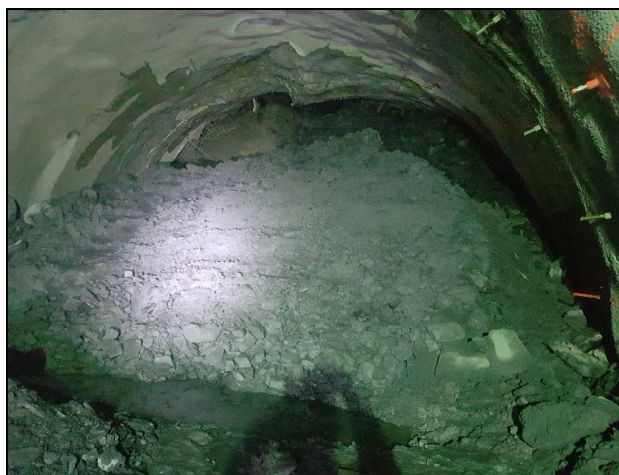
Слика 22.35 Појава на нестабилност на челото на ископ кај тунел „Пресека“ (фотографија од Д. Мославац)
