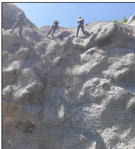
Слика 21.21 Заштита на косини со квадратна „Q” арматурна мрежа, прскан бетон и анкери на пат Велес - Градско кај стрмни косини, со помош на алпинисти (фотографија на В.Трајановски)
