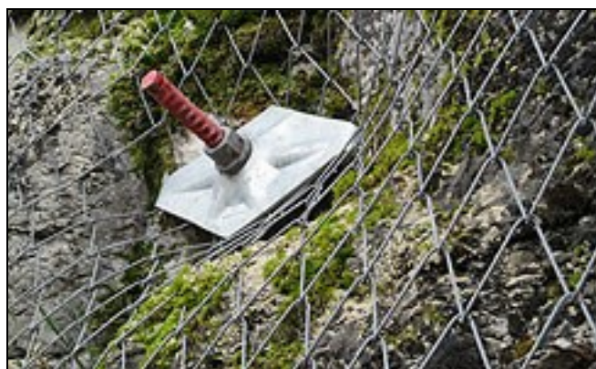
Слика 21.15 Заштитна мрежа, зајакната со анкери
