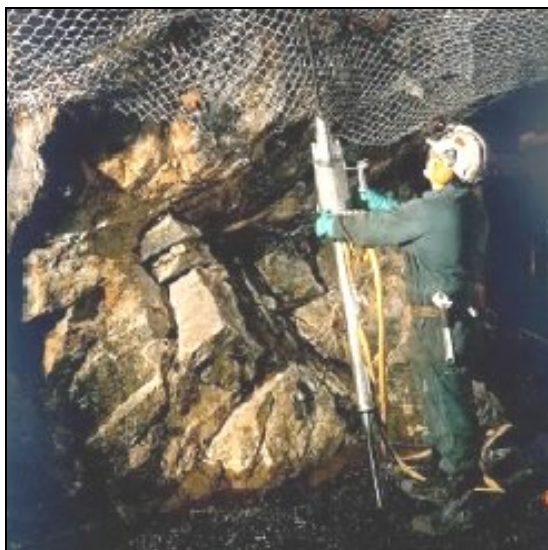
Слика 18.37 Мануелно вградување на сидра во подземен ископ
