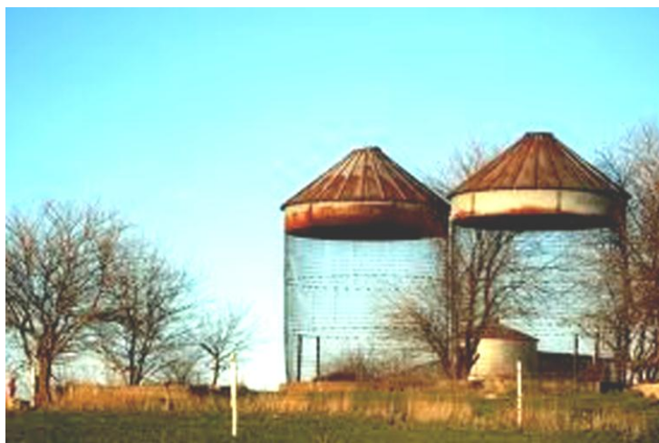
Слика 99. Објекти за чување на ролни бали
